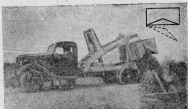
Фиг. 219. Автомашина типа Демистер со съемным кузовом грузоподъемностью 1,5 т.
