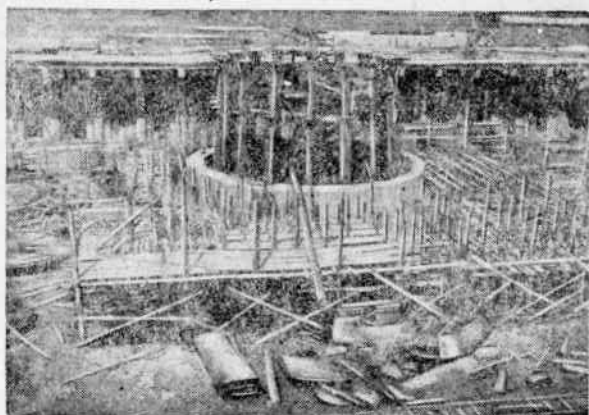
Фиг. 85 Вид колонн, установленных на опорное кольцо.
