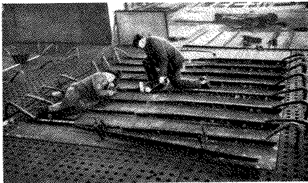
Abb. 254. Schweißen eines Schotts auf der Spannplatte.
