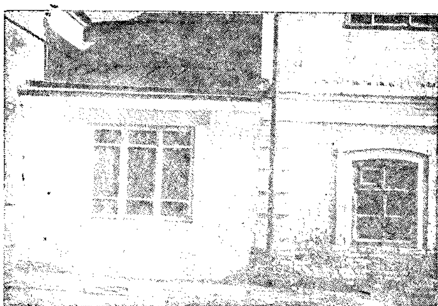
Рис. 21. Опытное здание из гипсовых блоков, построенное на территории ГИСИ в 1937 г.
