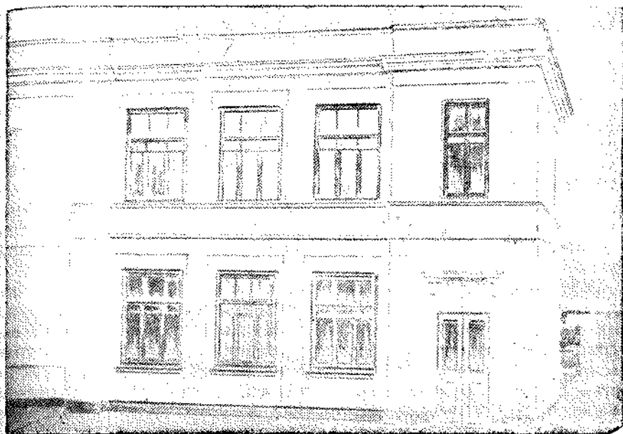
Рис. 22. Фасад здания лаборатории при кафедре строительных материалов ГИСИ.
