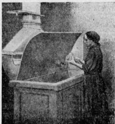
Фиг. 28. Ванна для мытья посуды с бортовым отсосом для удаления загрязненного воздуха.
