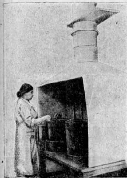
Фиг. 25. Разлив смоляного клея в клеянки под тягой.
