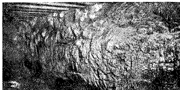
Рис. 210. Шлакование верхней шамотной части топки.
