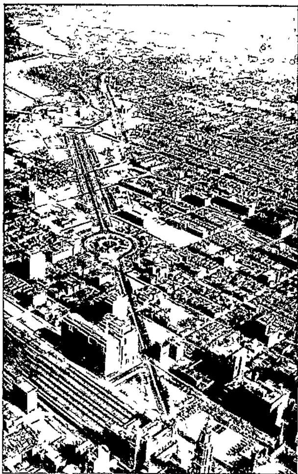
290. Филадельфия. Общий вид диагональной улицы. На первом плане — башня фатуши, левее — поповый Центральный вокзал
