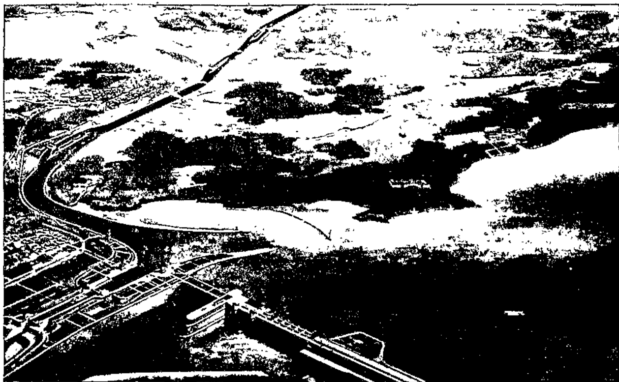
348. Канал Москва—Волга. Шлюз № 1 (со стороны верхнего бьефа)
