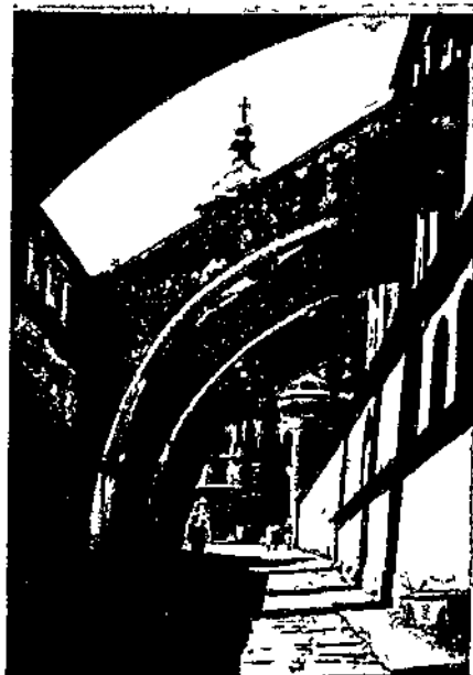
112. Кievo-Печерская лавра. Контрфорсы собора
