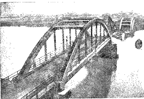
Рис. 18. Мост через р. Одер после катастрофы.
