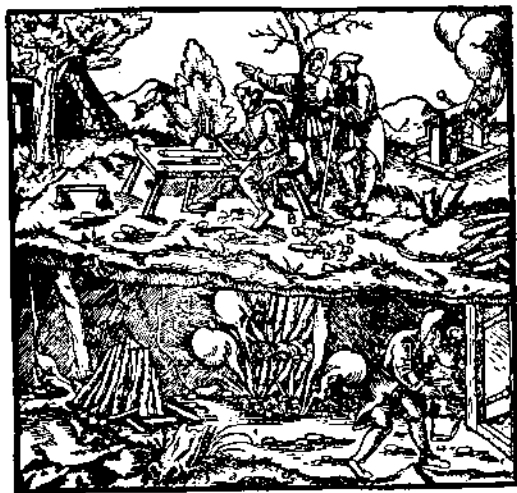
Рис. 28. Огневой способ ломки породы в штольне. Гравюра из сочинения Георгия Агриколы (XVI в.).
