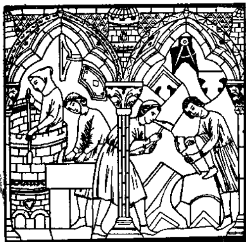
Рис. 13. Обработка камня (кирка, зубило); проверка кладки отвесом; наугольник, циркуль. Витраж Шартрского собора, Франция (XIII в.).
