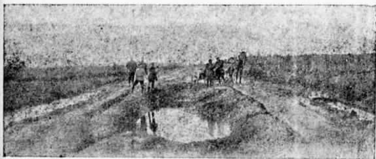
Фиг. 22. Опускание насыпи между торфяными буграми.
