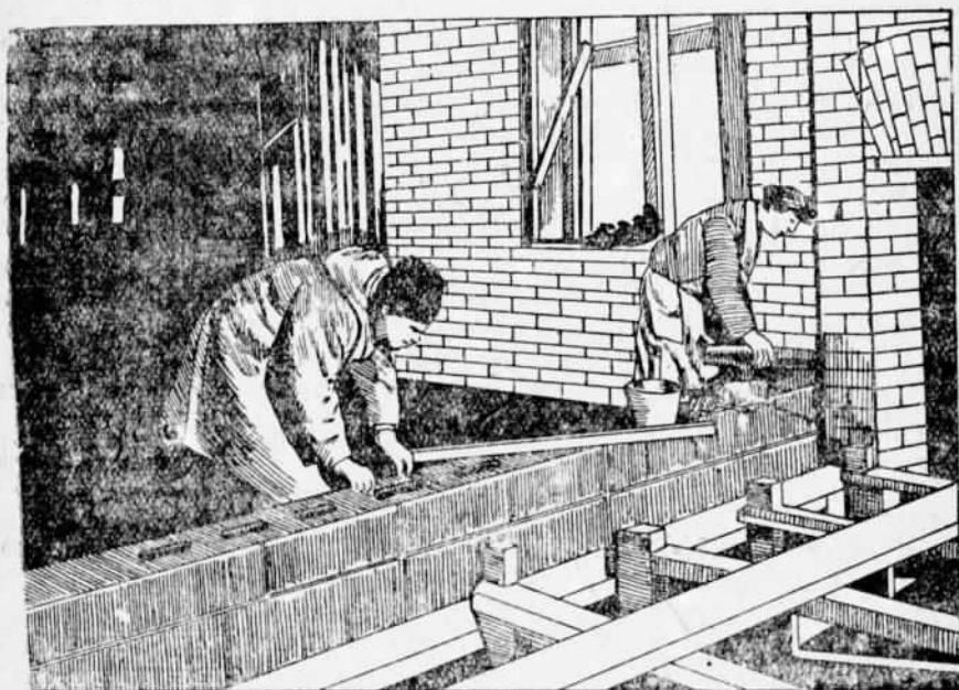
Рыс. 32. Кладка са шлака-бетонна-апілачных камянёў.
