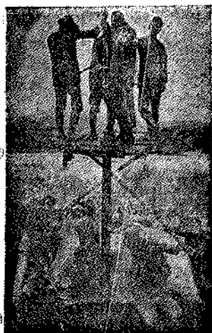
Рис. 257. Разведка бурением залежей россыпного олова на о. Бангка.
