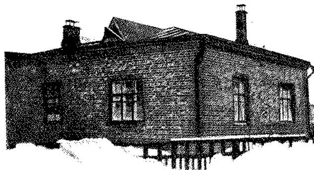
Рис. 26. Опытный дом со стенами в 2\frac{1}{2} кирпича.
