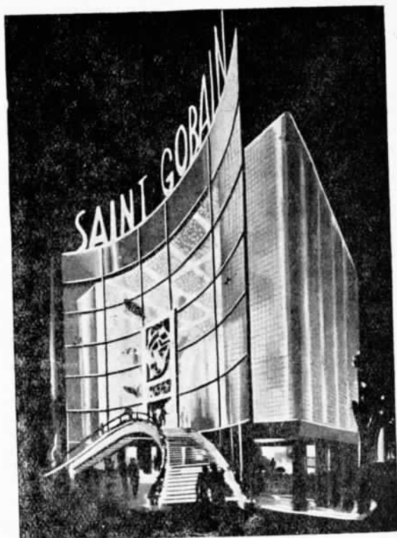
Рис. 99. Здание из стеклянных блоков, построенное на Парижской выставке фирмой Сан-Гобен
