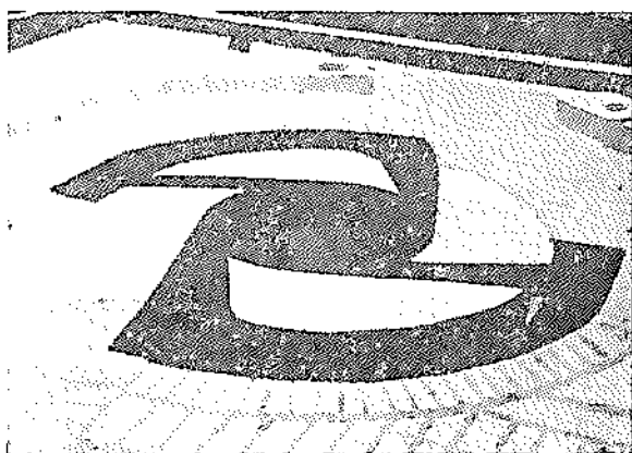
Рис. 25. Тангенциальная горелка Тейзена во время кладки печи
