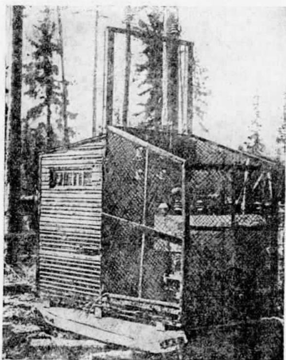
Рис. 208. Передвижная понизительная трансформаторная подстанция.
