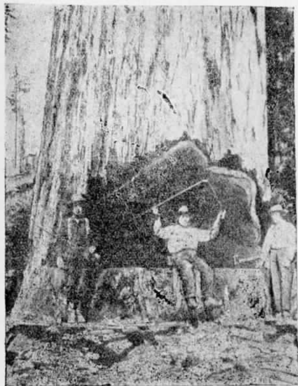
Рис. 179. Подруб топором секвой в Калифорнии.
