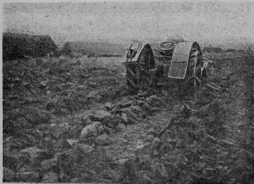
Фиг. 14. Вид карты после прохода колесного трактора с плугами-расчистителями.
