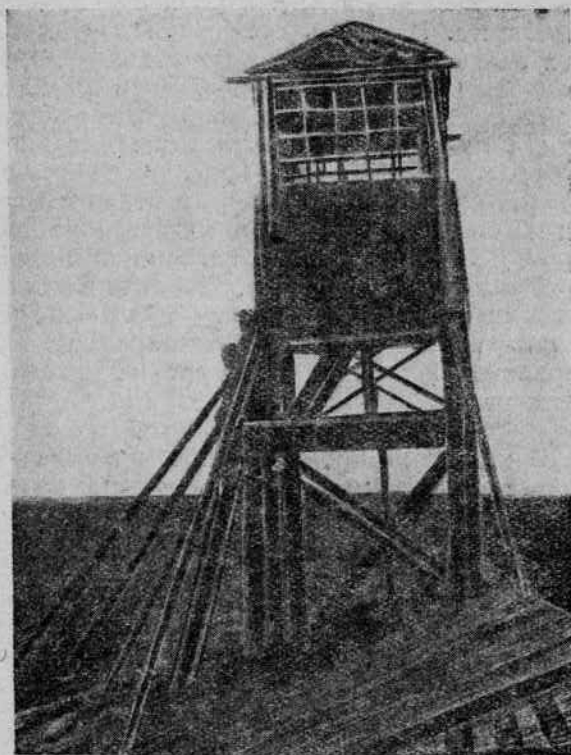
Фиг. 3. Диспетчерский пункт, устроенный на крыше гаража.
