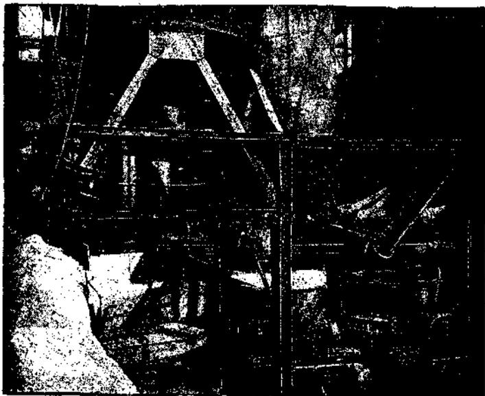
Фиг. 6. Откидной жолоб для грануляции шлака у доменной печи (завод им. Сталина).
