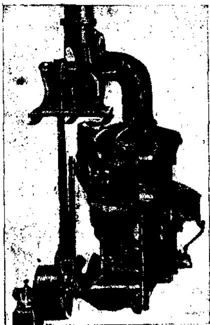
Фиг. 31. Мельница Фуллера с воздушной сепарацией угольной пыли.
