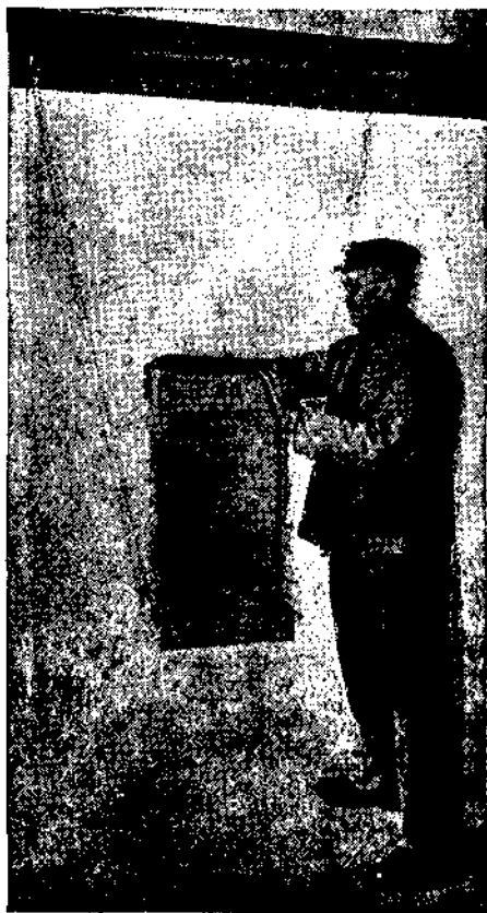
№ 18. Приспособление для просева отощателя
