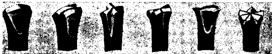
Рис. 6. Головки буров.
