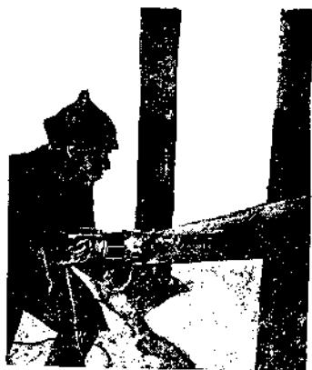
Рис. 68. Сбаливание схваток.
