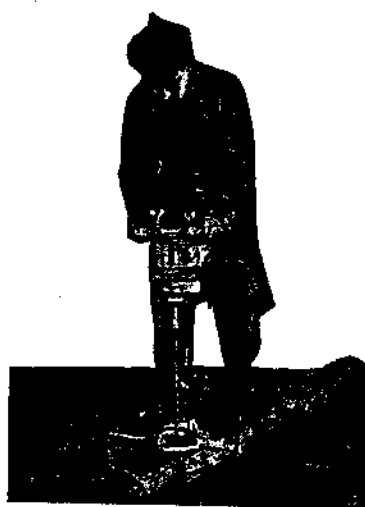
Рис. 62. Сверление вертикальных дыр.
