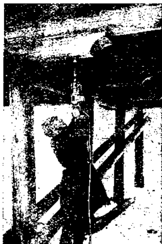
Рис. 70. Сбаличивание переводни.
