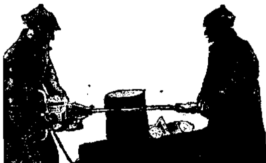
Рис. 26. Пилка головы свай.
