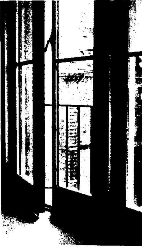
Innenansicht. Der aufgedoppelte Rahmen (heller gestrichen) wird mit Einreibern verschlossen
