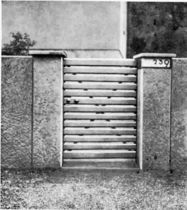
Die Latten sind für das Abfließen des Regenwassers schräg abgefast
