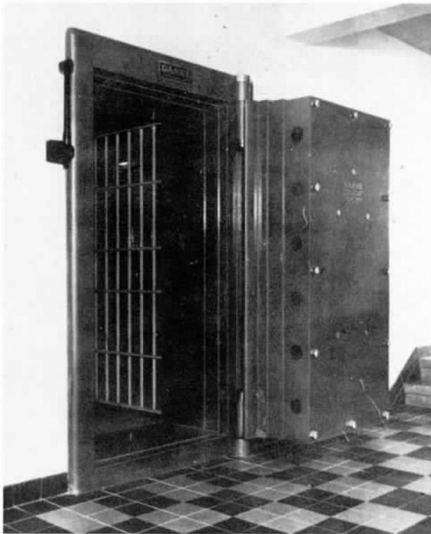
Tresortüre von Franz Garny, Frankfurt a. M. Gesamtstärke 40 cm, Gewicht 100–120 Zentner. Die Türe bewegt sich spielend leicht in Kugellagern. Der Verschluss erfolgt durch ein Zentralriegelwerk ohne sichtbares Schlüsselloch. Fernschlüssel von außen nicht feststellbar mit über 40 Millionen Einstellmöglichkeiten durch Zahlen.
