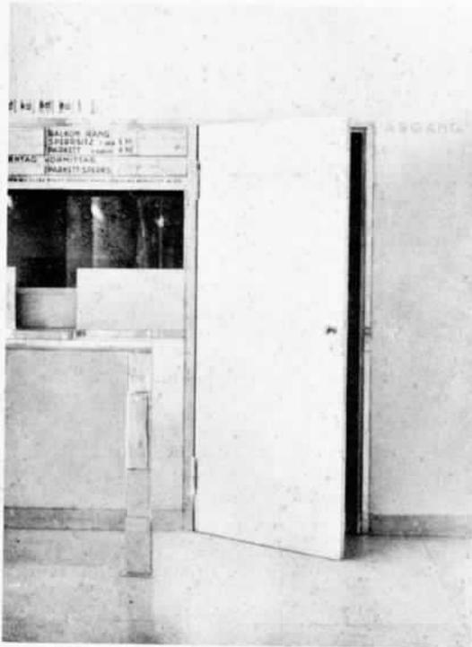
Glatte, weißlackierte Türe mit Fischband und Einsteckschloß in vernickelter Metallzarge angeschlagen
