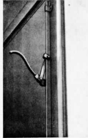
Treibriegelverschluß mit Hebel
