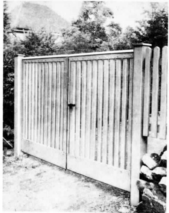
Der linke Flügel ist gewöhnlich fest und wird mit einer Verbindungsstange oben und einem Riegel unten festgehalten (s. unten)
