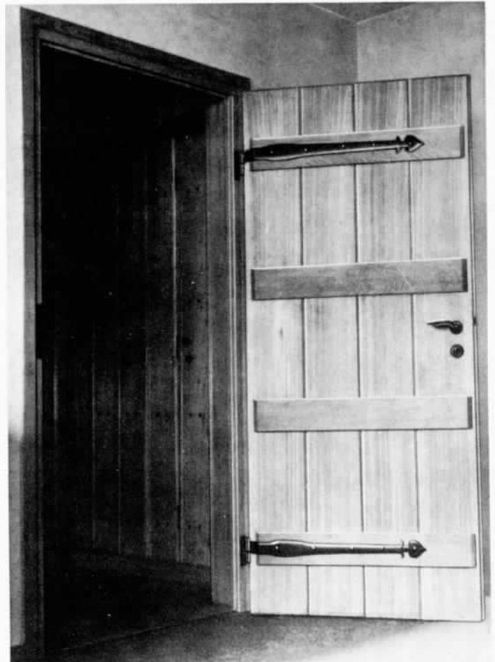
6 Gespundete Bretter mit eingeschobenen Gratleisten. Angeschlagen mit Langband. Einsteckschloß
