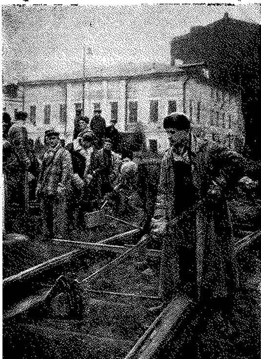
Фиг. 58. Подъемка рельсов рычажным домкратом.
