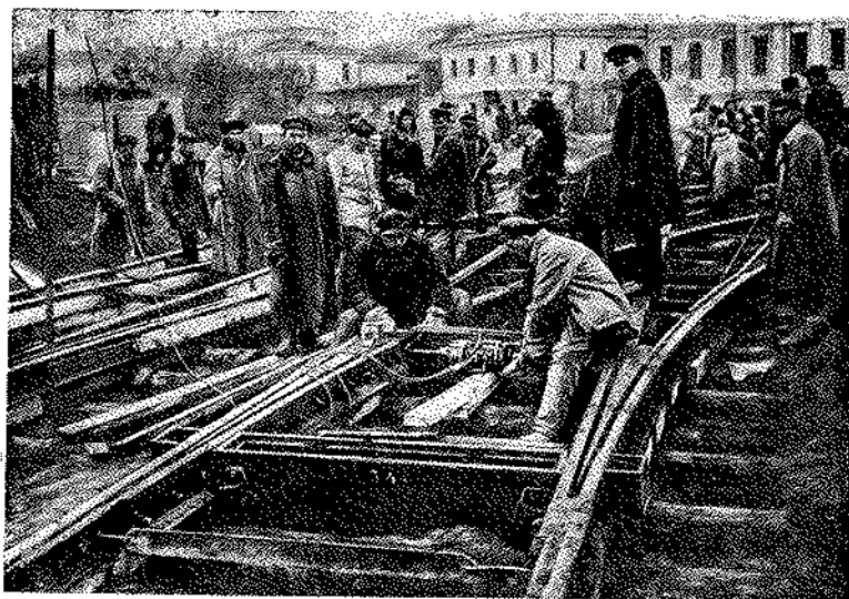
Фиг. 61. Сверление рельсов электродрелью.
