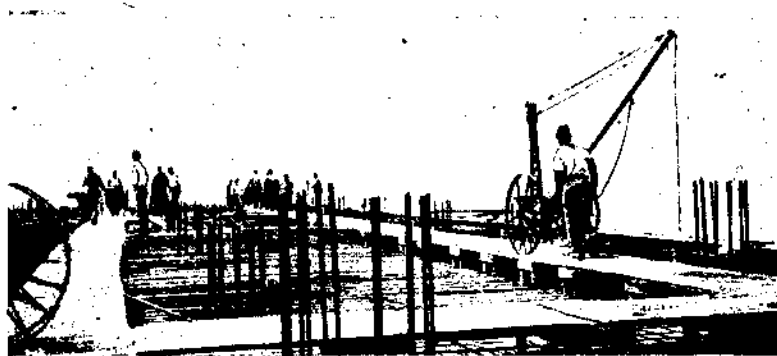
Рис. 56. Прокаты для двухколесных тачек.
