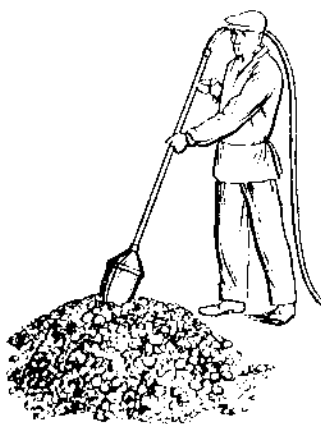
Рис. 88. Управляемый первивибратор Днепростроя.
