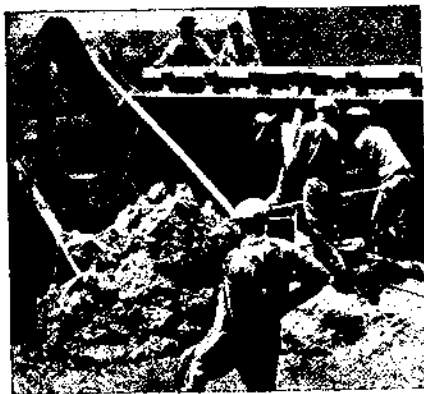
Рис. 78. Поверхностное вибрирование. До вибрирования.
