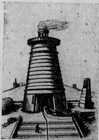
Рис. 10. Английская домна, работающая на горячем дутье. 50-е гг. XIX в.
