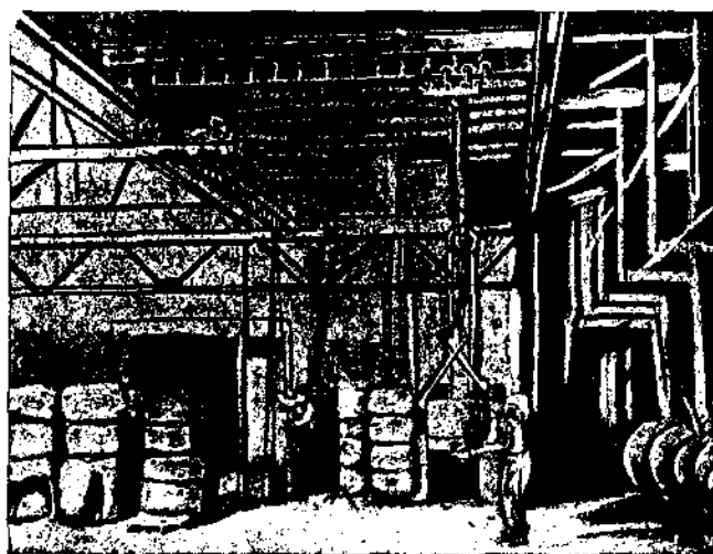
Рис. 23. Подвесная дорога в литейной.
