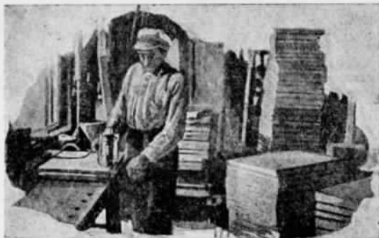
Рис. 204. Фанерная кантовочная пила с электрическим приводом
