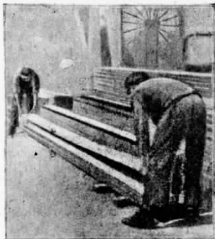
Рис. 172. Укладка смазанных клеем блоков
