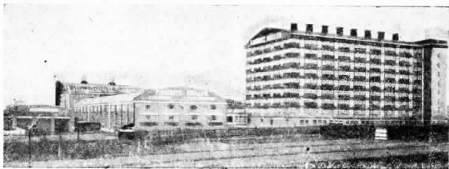
Рис. 70. Между пожарным депо и многоэтажным сушильным помещением виден фасад строгального цеха
