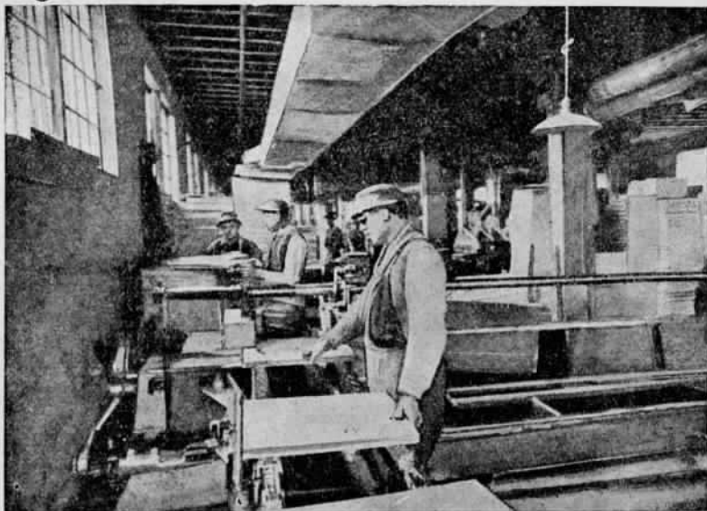
Рис. 200. Двойная обрезная пила с цепным транспортером
