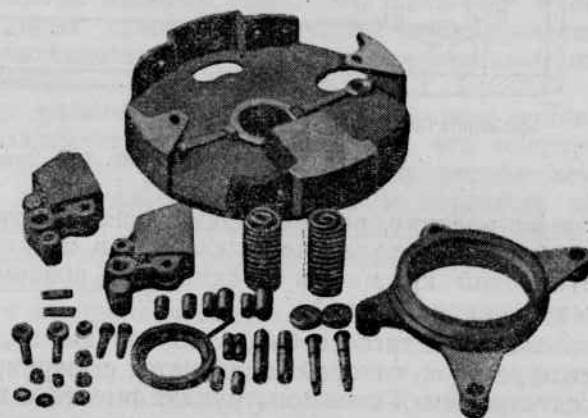
Фиг. 111. Детали регулятора локомотива типа П.
