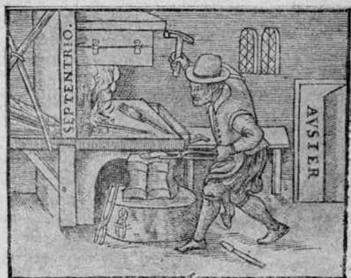
Путемковки куска железа, помещенного в направлении с севера (Septentrio) на юг (Auoster), можно намагнитить его (рисунок из соч. Джильберта: „О магните“).
