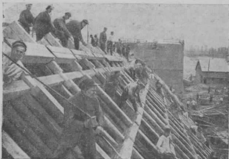
Рис. 98. Сборка ряжей Шаваньской плотины.
