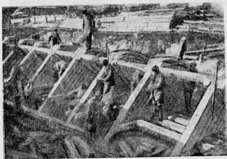
Рис. 102. Контрфорсы низкого профиля Выгостровской плотины.
