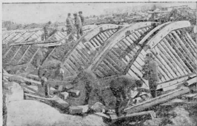
Рис. 56. Устройство оголовка и сливной грани.
