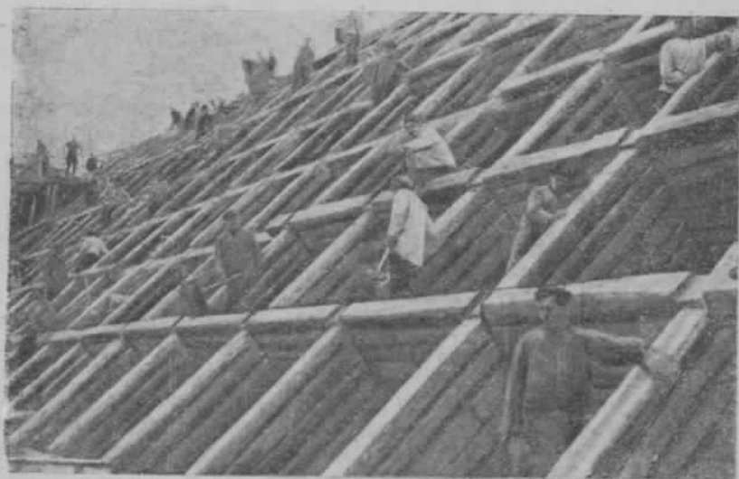
Рис. 99. Подъем бревен при сборке ряжей.
