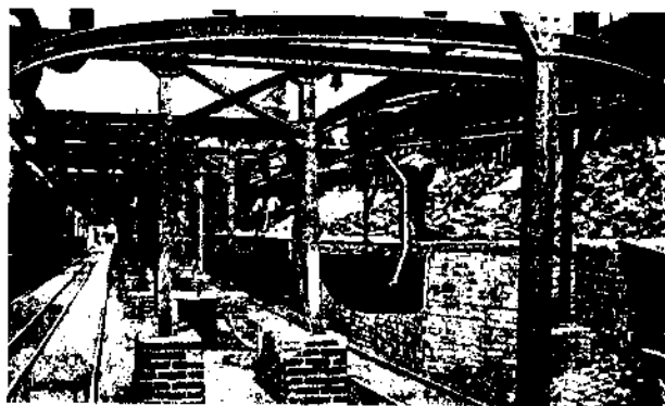
Фиг. 57. Нагрузка вагонеток электро-подвесной дороги коксом у коксовых печей.
