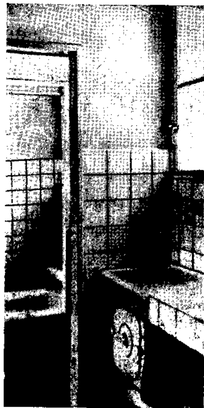
Рис. 21. Вид кухни с расположением раковины для удаления мусора (сист. „Гаршей“)
