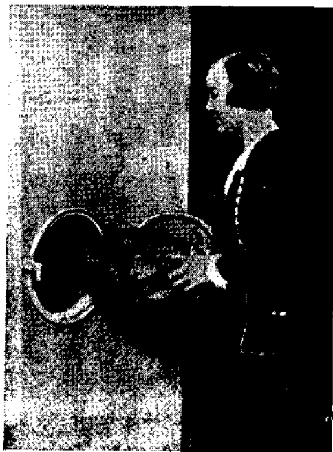
Рис. 3. Приемное отверстие мусоропровода. Мусор подается в пакетах
