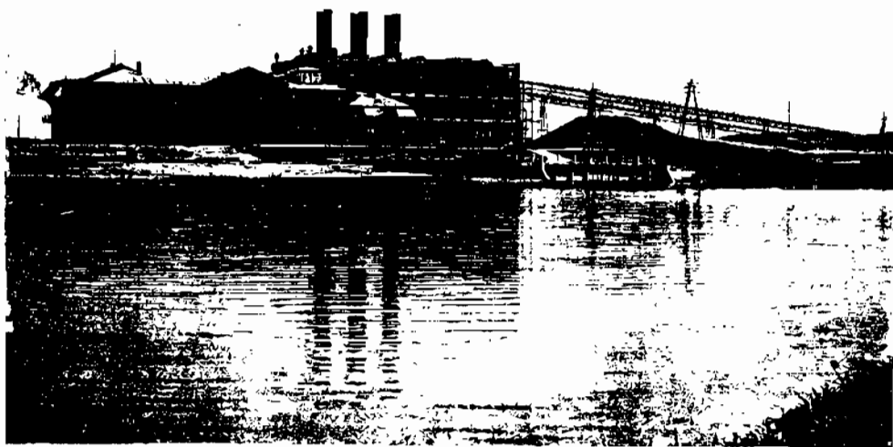
фиг. 1. Нижегородская районная электрическая станция.
