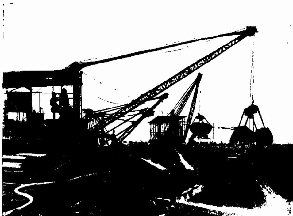
Фиг. 3. Вид установки в начале карьера (размыв воронки).
