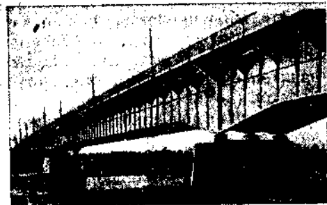
Фиг. 98. Неразрезной мост со сплошной стенкой и увеличением высоты балок у опор (р. Эльба у Дрездена)
