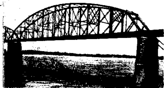
Фиг. 16. Мост через р. Миссисипи у С. Луиса (1889 г.), пролетом 158 м с шпренгельной решеткой
