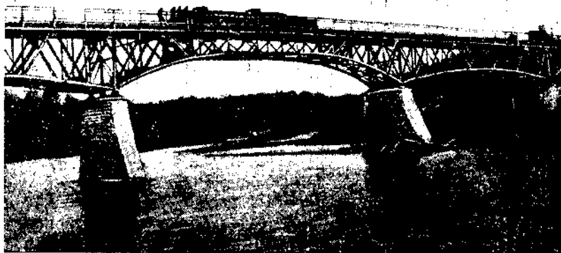
Фиг. 163. Общий вид консольно-балочного моста через Москва-реку у Старой Рузы
