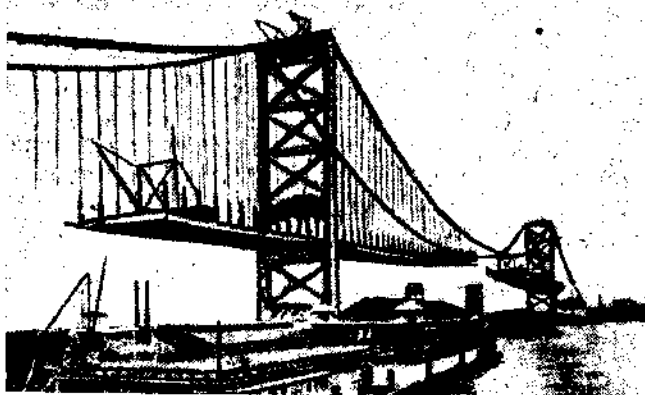
Фиг. 365. Сборка подвесной части висячего моста
