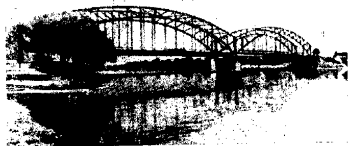
Фиг. 26. Мост через Русановский проток в Киеве пролетом 101,4 м (1905 г.)
