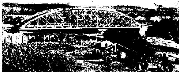
Фиг. 15. Мост через р. Ханис-Цхали на Военно-Землянской дороге (1898 г.)
