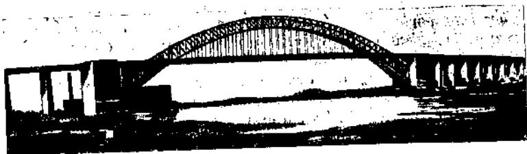
Фиг. 29. Мост Кил-Ван-Кул пролетом 511 м (1931 г.)
