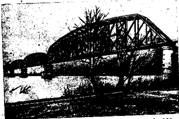
Фиг. 18. Мост «Метрополис» через р. Огайо l=220 м (1916 г.)
