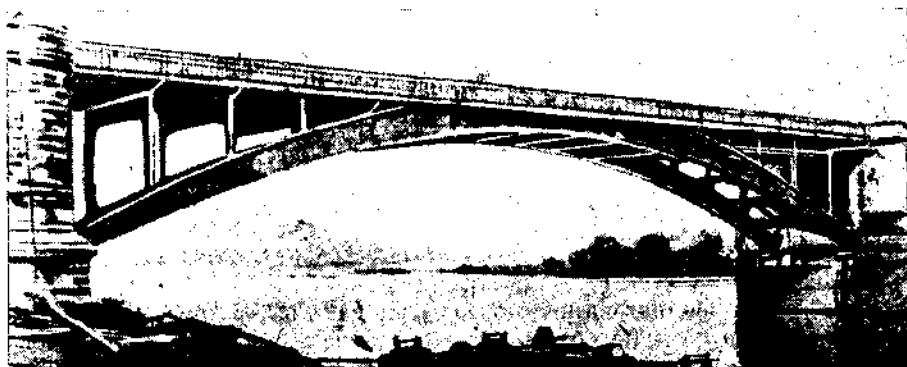
Фиг. 178. Арочный мост со сплошными арками
