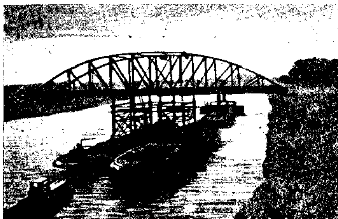
Фиг. 354. Подвозка на плаву готового пролетного строения
