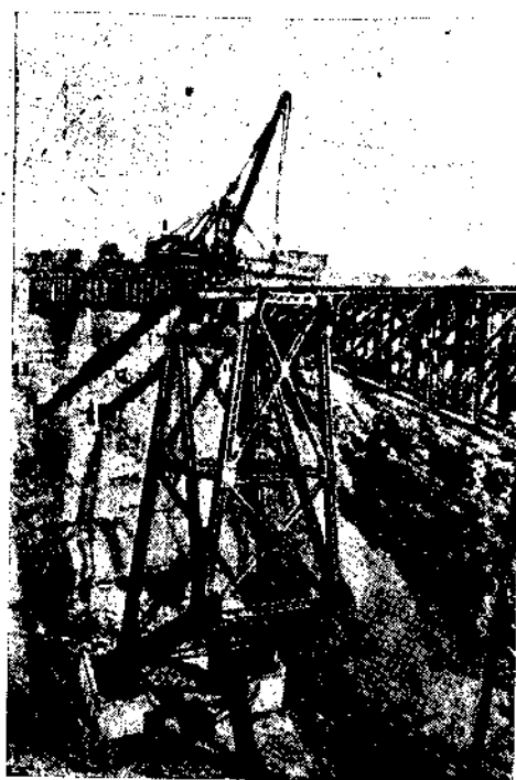
Фиг. 361. Навесная сборка арочного моста
