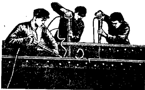
Фиг. 337. Клепка металлической фермы пневматическим молотком
