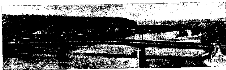
Фиг. 96. Мост со сплошной стенкой и криволинейным очертанием нижнего пояса (р. Рейн у Кобленца)
