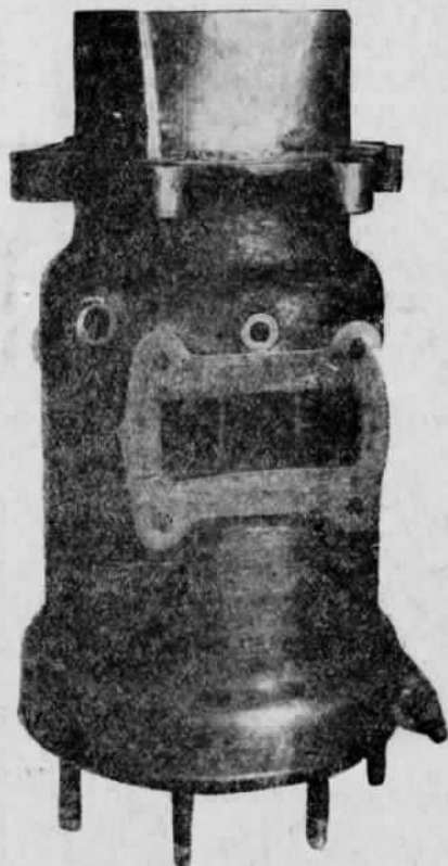
Рис. 97. Цилиндр дизеля в 45 л. с., подготовлен для сварки.
