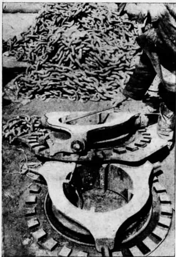
Рис. 105. Чугунные храповики. Обмер храповика перед постановкой на воробу (Союзфото)
