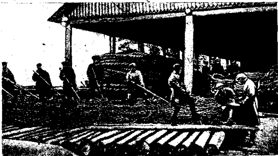
Рис. 72. Склад цепей. Цепи раскладываются на помосте из бревен. Растаскивание цепей производится специальными крючьями
