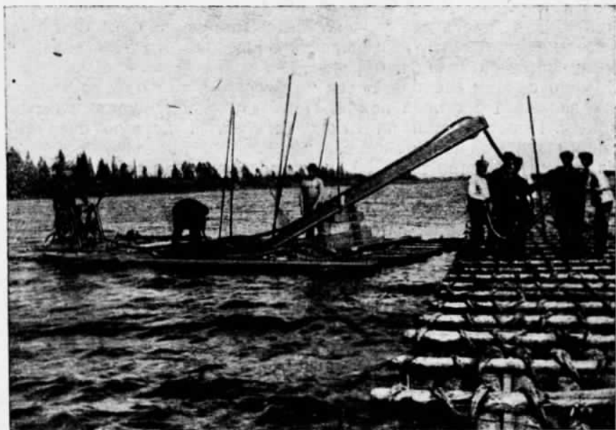
Рис. 99. Пловучий кран для подъема якорей. Кран представляет собой плот, на котором поставлена ручная лебедка и установлена стрела
