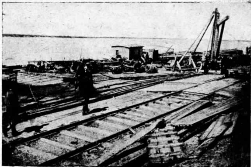
Рис. 100. Такелажная база. Схема базы приведена на рис. 102. Средняя площадка, через которую проходит ж.-д. ветка. На площадке установлен кран для погрузки и выгрузки такелажа с железной дороги
