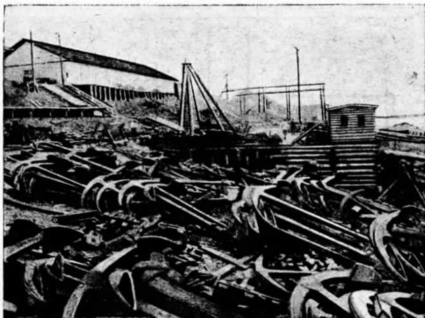
Рис. 101. Такелажная база. Склад якорей. Вверху виден склад, расположенный на верхней площадке базы
