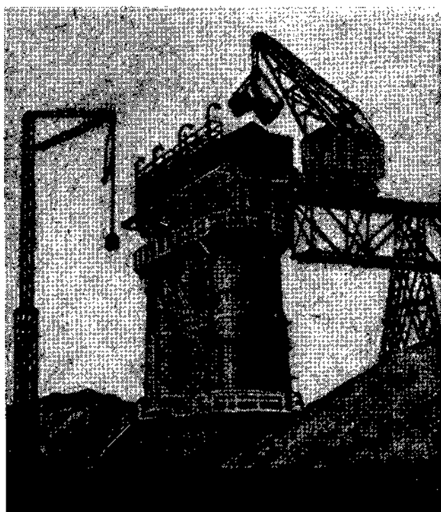
Рис. 23. Шахтная печь для обжига известняка.
