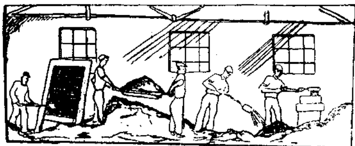
Фиг. 78. Ручное приготовление земли на месте изготовления форм.
