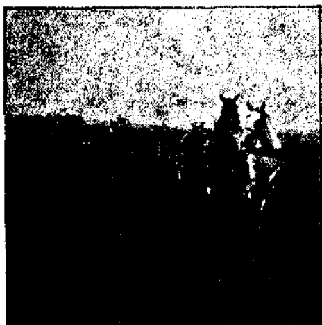
Фиг. 6. Вспашка целины после расчистки трассы перед пуском скреперов (лопат).
