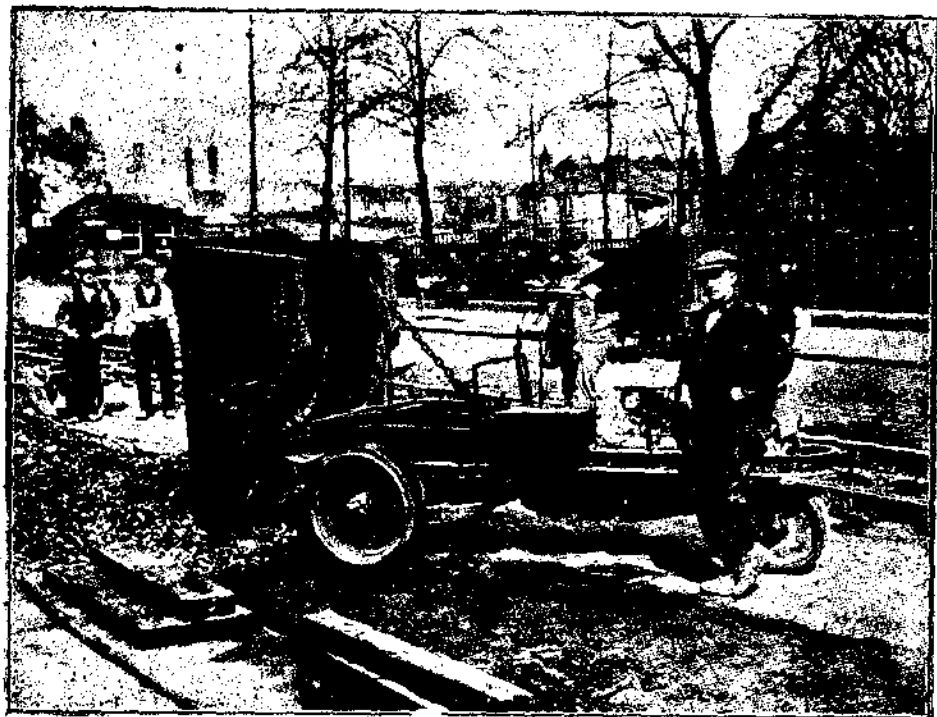
Фиг. 110. Грузовичок-электрокар, самосвал системы Миллерс, обслуживающий дорожно-строительные работы.
