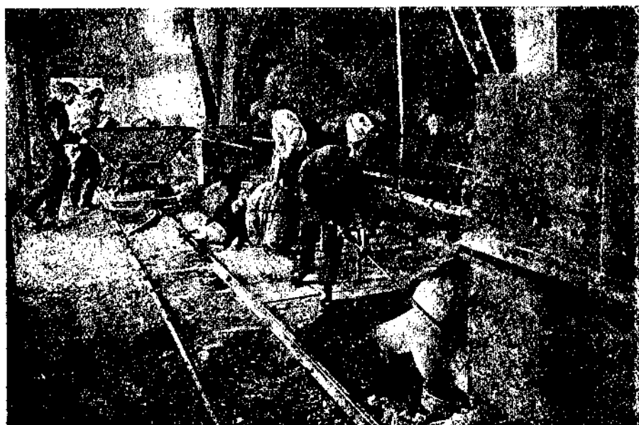
Фиг. 57. Загрузка шлаком роторных камнедробилок.
