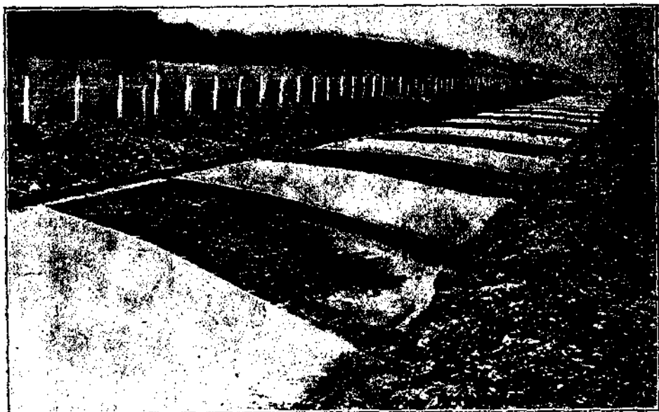
Фиг. 103. Железобетонная одежда дороги с арматурой Максвелл. При производстве работ плиты устраиваются с пропуском через одну.
