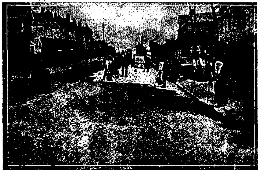
Фиг. 47. Пропитывание вручную щебеночного шоссе эмульсией «таролеум».
