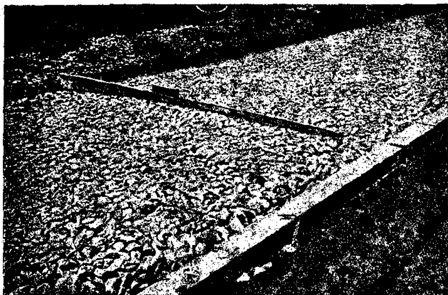
Фиг. 93. Устройство цементно-щебеночного шоссе. Слегка укатанная россыпь щебня перед пропитыванием сухим цементным раствором
