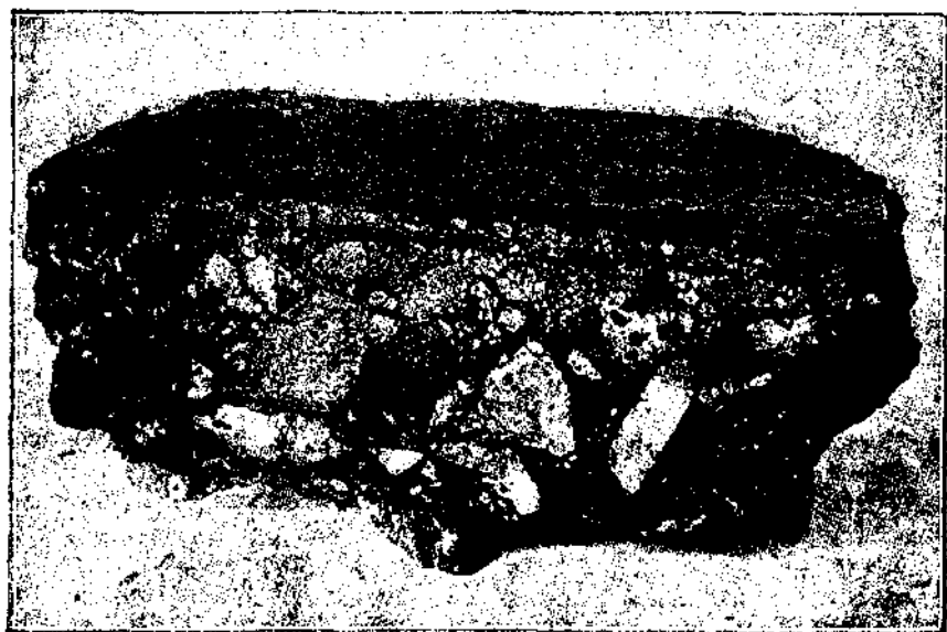
Фиг. 60. Образец тармакадама, вынутый из одежды после 14-летней службы. Обращается внимание на поверхностную обработку.
