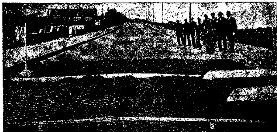
Фиг. 90. Железобетонная дорога, построенная с применением высокодействующего цемента «Феррокрит» и рулонной арматуры «Экспамет».
