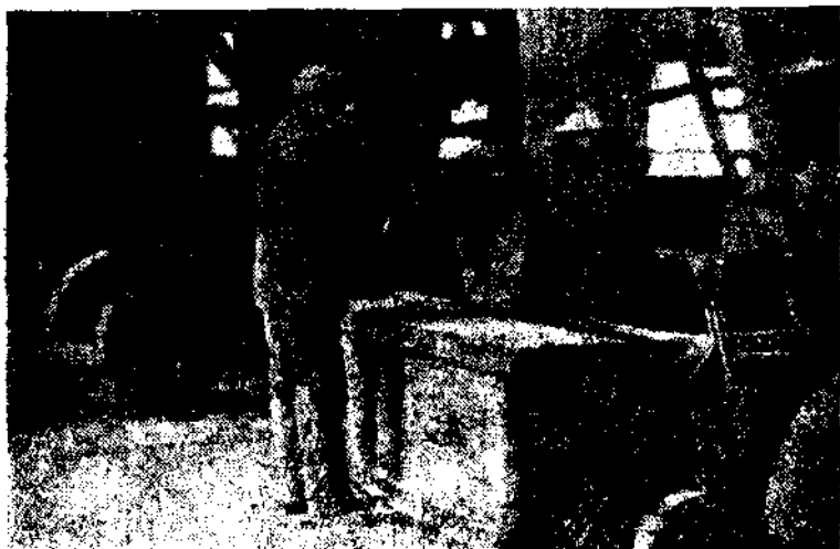
Фиг. 59. Производство тармакадама с применением шлака (асфальтовый шлак Шенкерд). Отмеривание дегтя для смешения с шлаком.
