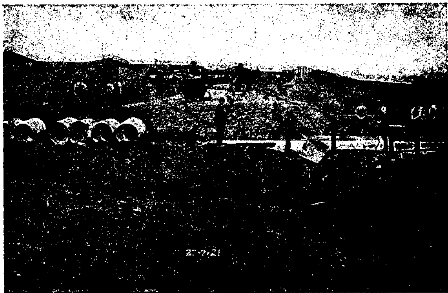
Фиг. 16. Укладка бетонных труб под насыпью.
