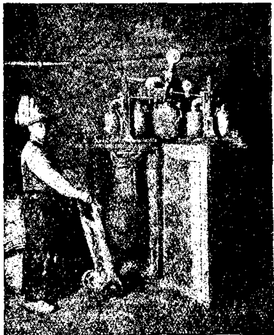
Фиг. 89. Автоматическое наполнение готовым цементом мешка со взвешиванием.
