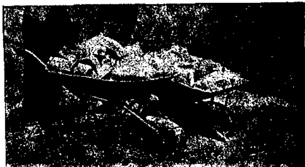
Фиг. 7. Гусеничная тачка, не нуждающаяся в досках для передвижения по ним. Обращается внимание на легкость, с которой она движется по плохому грунту.
