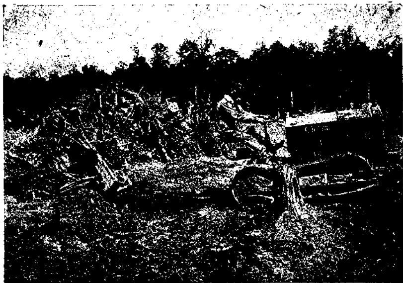
631. Перетаскивание пней трактором.
