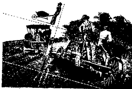
609. Сравнительное преимущество машины с наклонными колесами.
