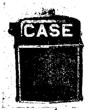
319. Радиатор «Кейс» одной из моделей, с натянутой на него проволоочной сеткой.
