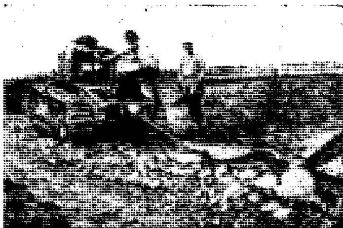
598. Разрыхление каменистого дорожного грунта рутером при помощи трактора («Рено»).
