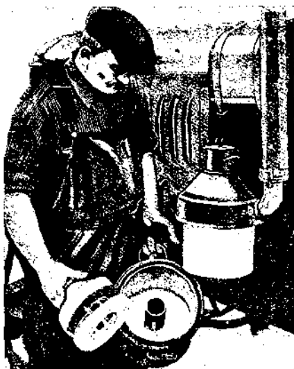
206. Воздушный фильтр тракторов «Интернационал» Мак-Кормик Диринг, 20-10 л. с. некоторых выпусков.
