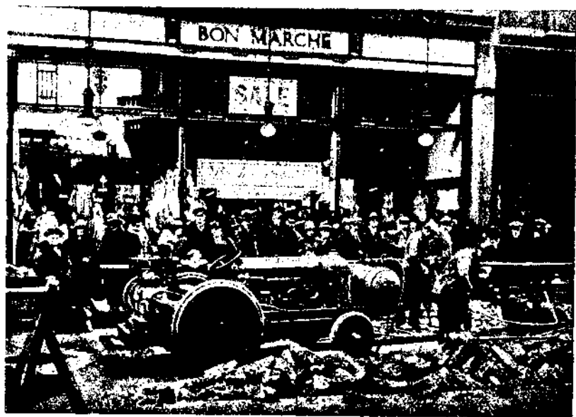
560. Компрессор на разломе бетонной мостовой.
