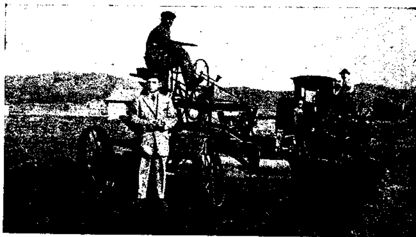
608. Вид струга «Адамс» с наклонными колесами.
