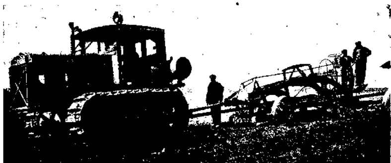
20. Трактор Катерпиллер на дорожных работах в совх. эе № 2 Зерновтреста.
