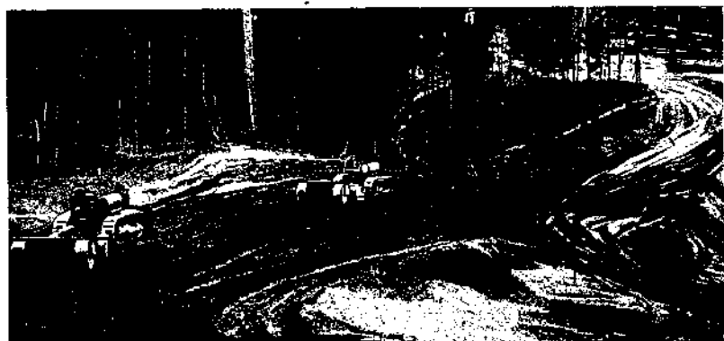
624. Тракторы «Катерпиллер» со скреперами «Мак-Миллан» на прокладке шоссе.
