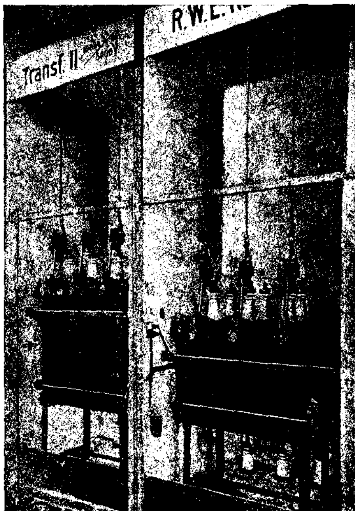
Фиг. 443. Ячейки масляных выключателей.
