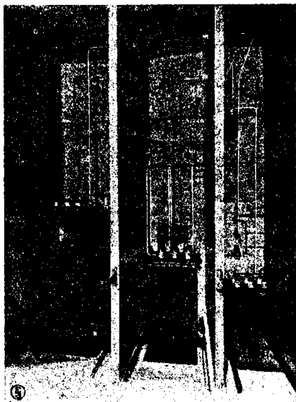
Фиг. 438. Дугогасящий трансформатор с регулирующим дросселем и масляным выключателем.
