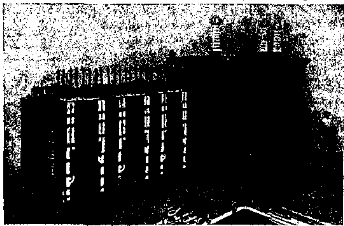
Фиг. 413. Трехфазный трансформатор, мощностью 60 000 kVA.
