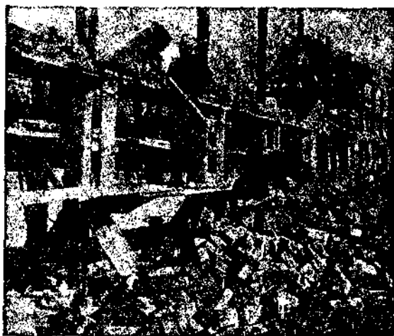
Рис. 46. Расположение подмостей подносчика.
