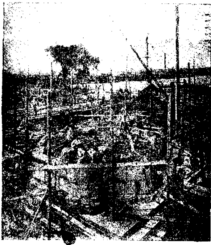
Рис. 63. Начало возведения внешних лесов.
