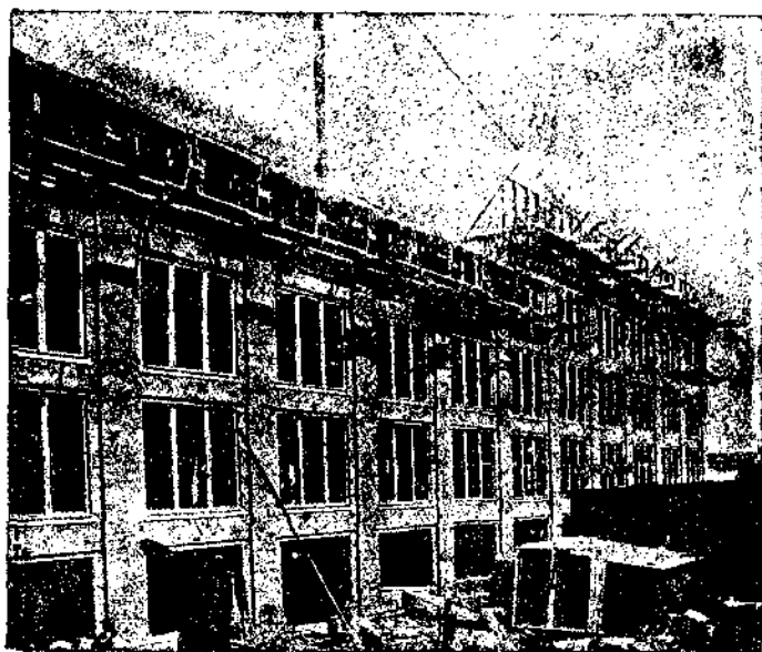
Рис. 28. Леса на выпускных пальцах для двух различных этажей одной и той же стены.
