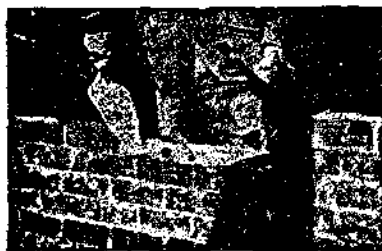
Рис. 92. Внешний лицевой вертикальный слой, работа справа налево, — набрасывание раствора.
