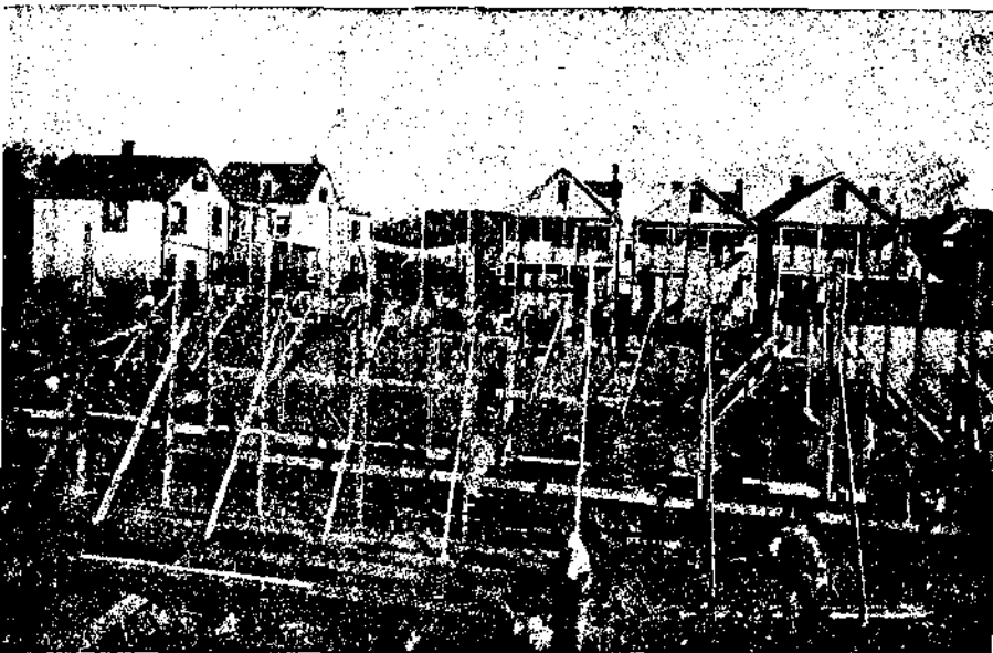
Рис. 24. Способ установки бостонских лесов.
