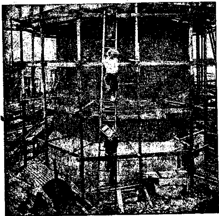
Рис. 65. Бостонские леса для кладки внешнего лицевого вертикального слоя. Обратите внимание на отверстие, оставленное в стене трубы для доставки материала к подъемнику.
