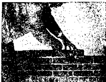
Рис. 101. Внутренний лицевой вертикальный слой, работа слева направо, — срезывание раствора после укладки кирпича.
