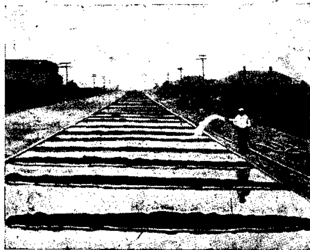
Рис. 181. Защита свежего бетона от рассыхания слоем воды, удерживаемой глиняными ровиками.
