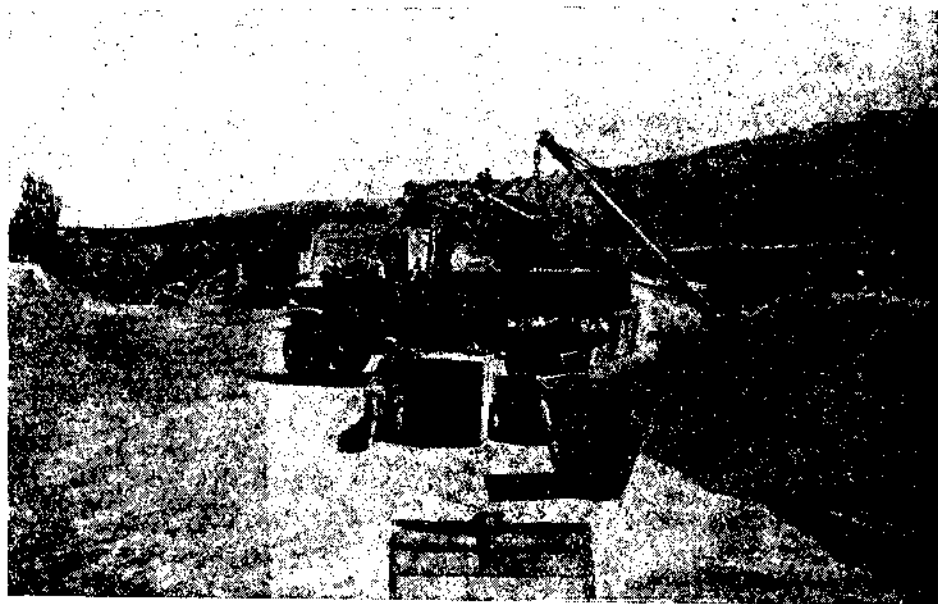
Рис. 189. Погрузка щебня в карьере на автомобиль. Применена поворотная стрела и мерный ящик с откидным дном. Симферополь.
