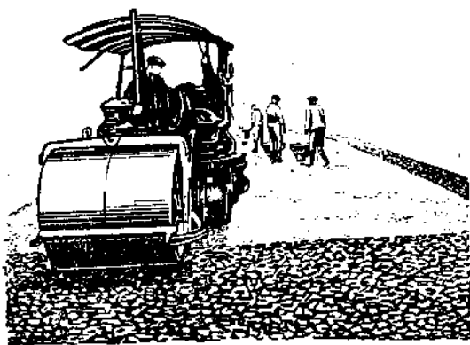
Рис. 225. Производство работ по постройке цементно-щебеночного шоссе.
