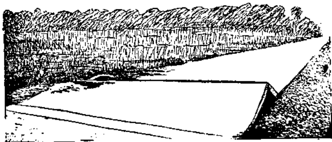
Рис. 207. Вид вспучившейся (поднявшейся при изломе) плиты.
