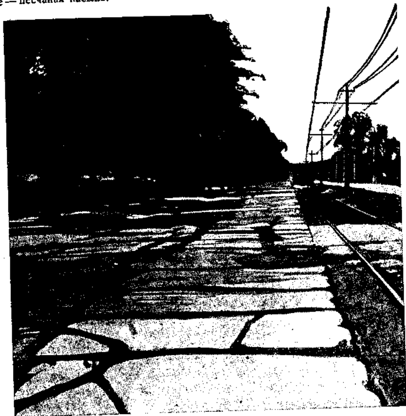
Рис. 24. Бетонная дорога после 20 лет службы. Ряд продольных, поперечных и косых трещин, заделанных битумом (SASIM).
