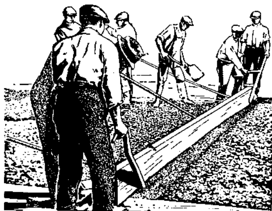
Рис. 114. Ручное трамбование бетона.
