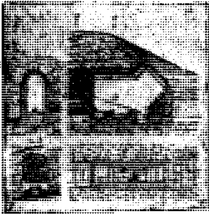
Фиг. 132. Каптажная камера с боковым входом.
