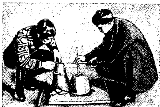
Рис. 19. Измерение осадки конуса.
