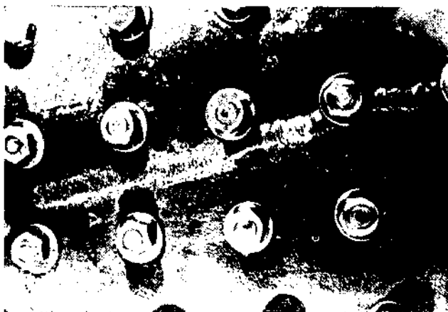
Рис. 26. Электрически заваренная трещина длиной 1100 мм в задней стенке парового котла. Котел после заварки работает беспрерывно с 1923 г.
