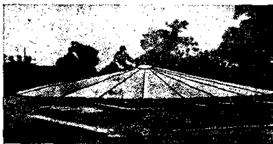
Рис. 80. Сварка двух половинок кровли в одно целое.
