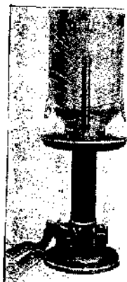
Рис. 22в. — Фонтанный пропариватель для молочной фляг.
