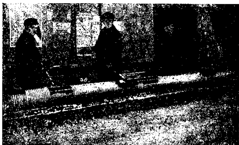
Рис. 60. Асфальтировка деревянных труб.
