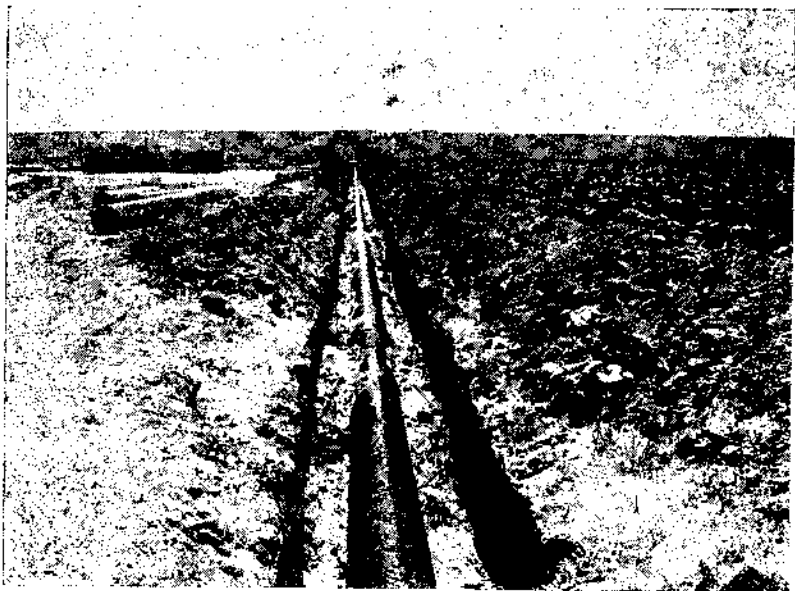
Рис. 101. Трубопровод \varnothing 300 мм для оросительных целей на остр. Хортица.
