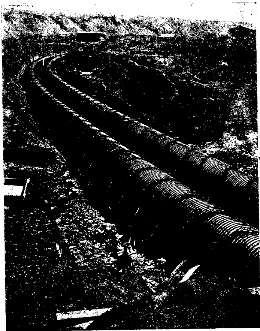
Рис. 105. Трубопровод Кузнецкого металлургического завода.
