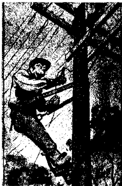
Фиг. 168. Работа на столбе с применением предохранительного пояса.
