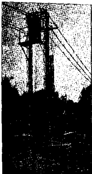
Фиг. 170. Опора с трансформатором, удовлетворяющая требованиям безопасности.
