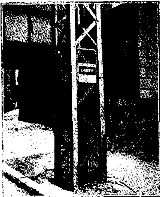
Фиг. 77. Ограждение опоры.
