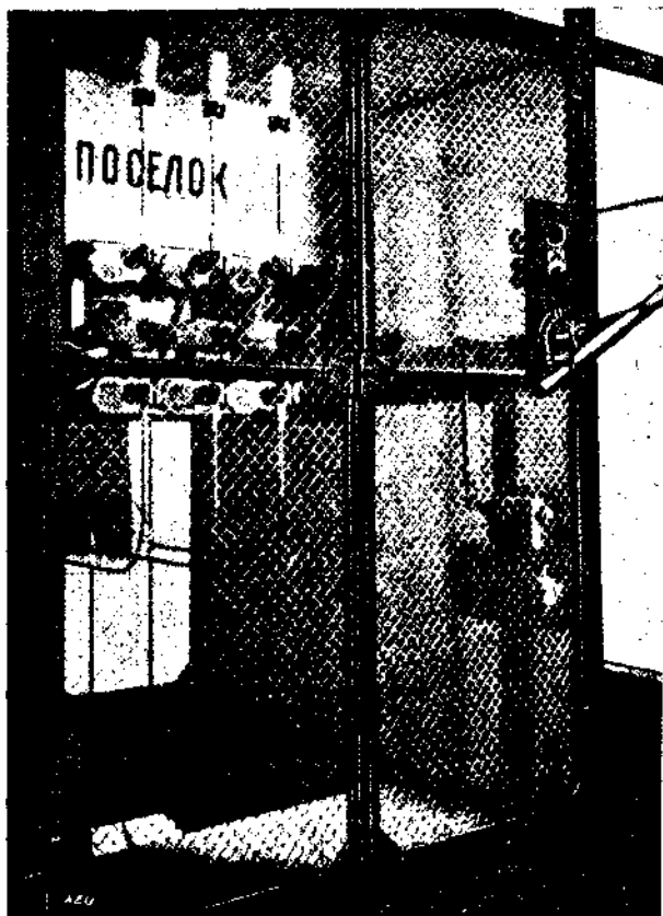
Фиг. 35. Камера, огражденная проволочной решеткой.
