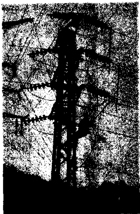
фиг. 142. Применение штанг для заземления и короткого замыкания воздушных проводов.
